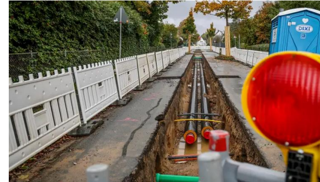
Fernwärmeleitung in der Clüverstraße; Quelle: Weser-Kurier / Strangemann (Stand: 09.04.2025)
