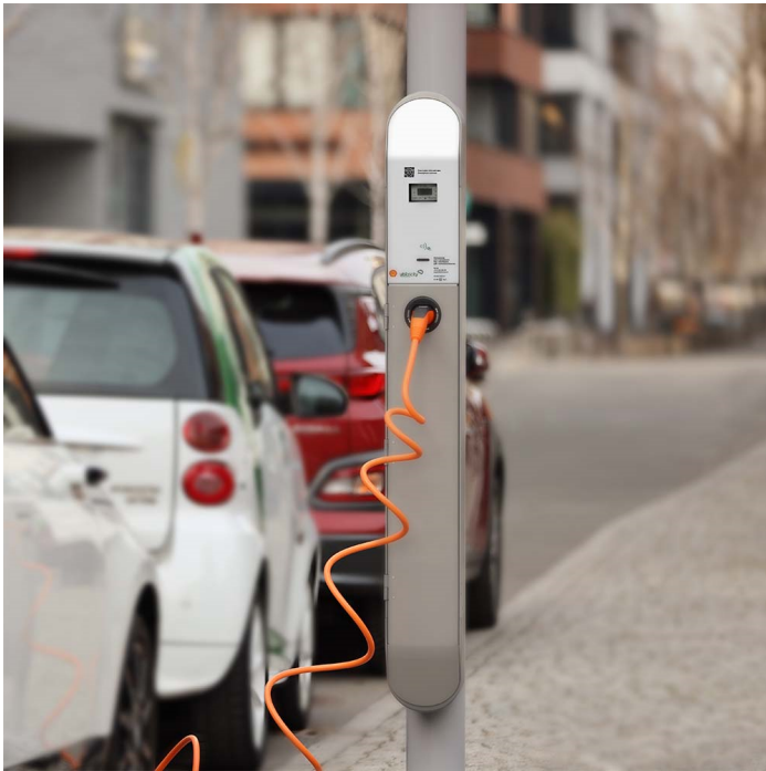
Abb: Lademöglichkeit für Elektrofahrzeuge an Straßenlaternen 18
