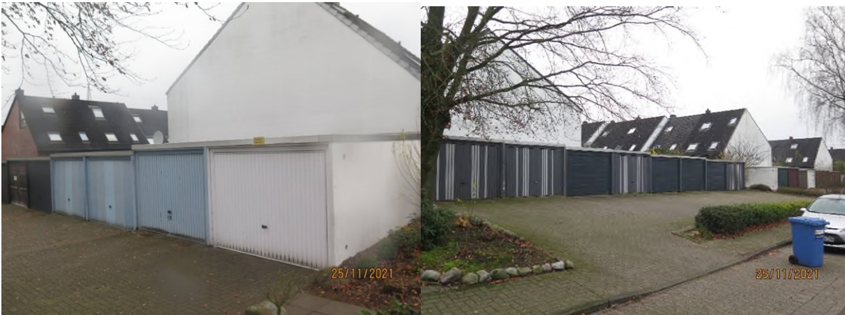
Abb: Garagen im Quartier
